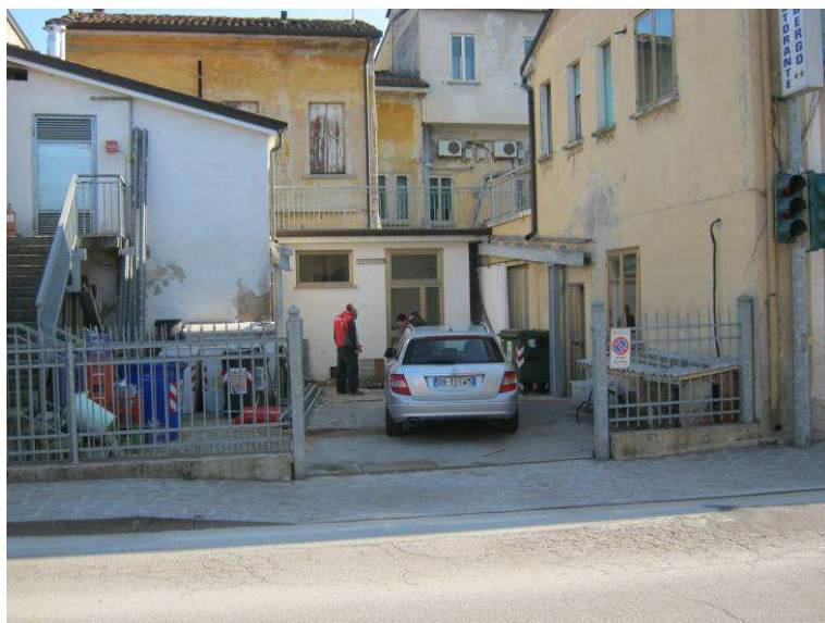
Foto n.1 Vista del sito d'intervento
